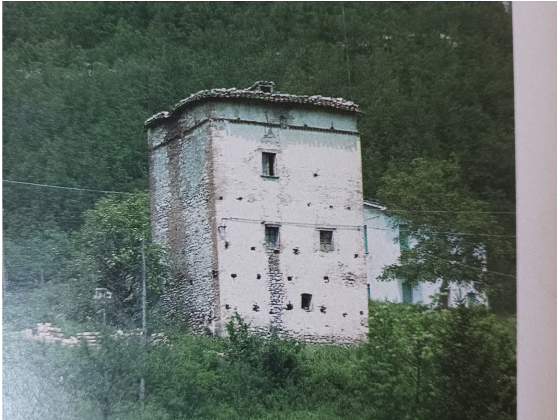
Casa torre primo metà XVI secolo Montefortino
